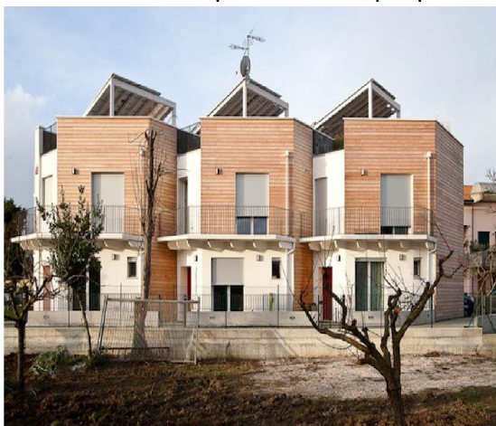
Figura 2- Villette a schiera in paglia realizzate da Archética a Fano
