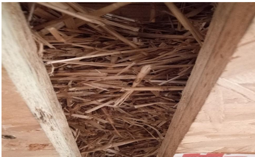
Figura 6 - Dettaglio interno parete, paglia compressa
